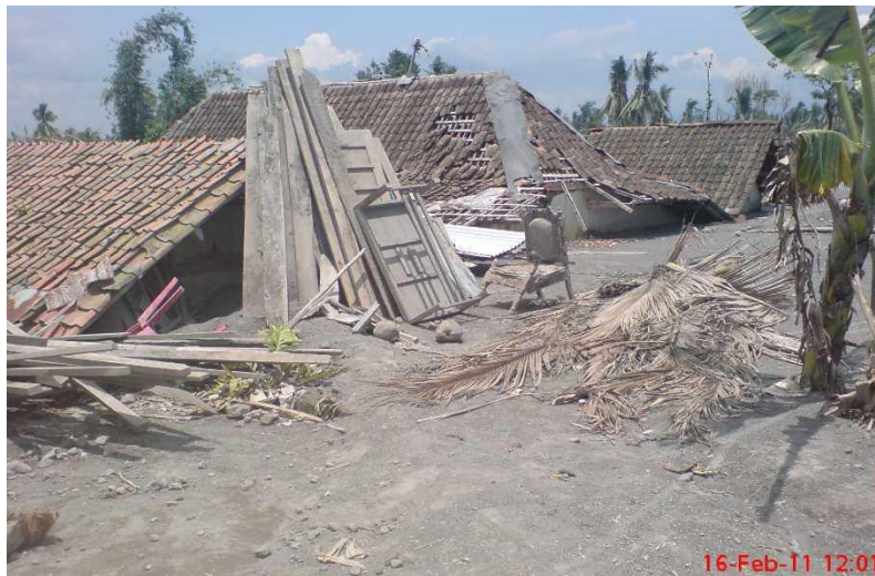
Gambar 1. Kondisi Rumah Terendam Pasir Akibat Lahar (Foto: Kumalawati, 2011)
