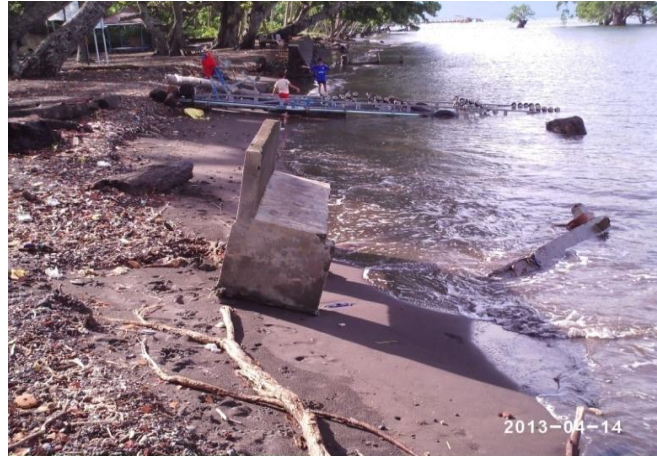
Gambar 2. Kerusakan Fasilitas Rekreasi yang Disebabkan oleh Gelombang di Wilayah Pesisir Kelurahan Kastela
